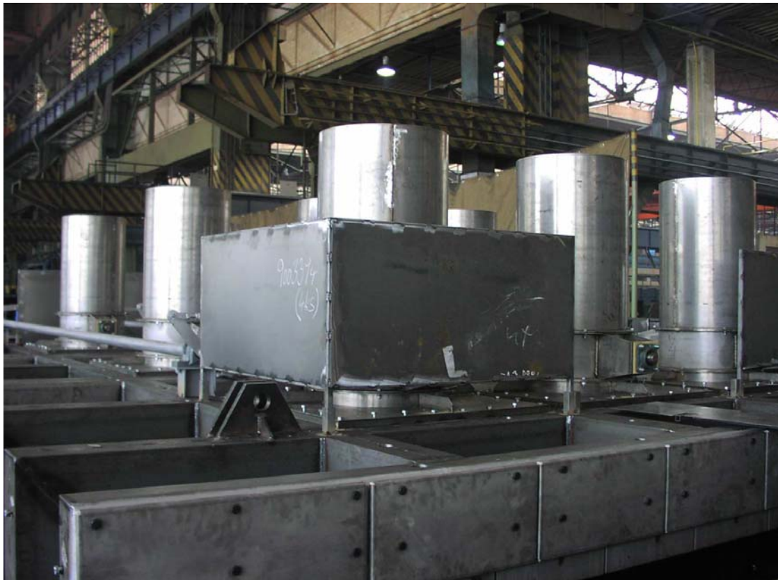
Obrázek 2 Pohled na horní část termokrytu s komíny
