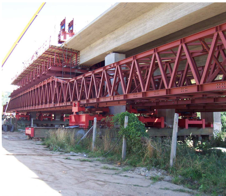
Obrázek 2: Přesuvná skruž.
